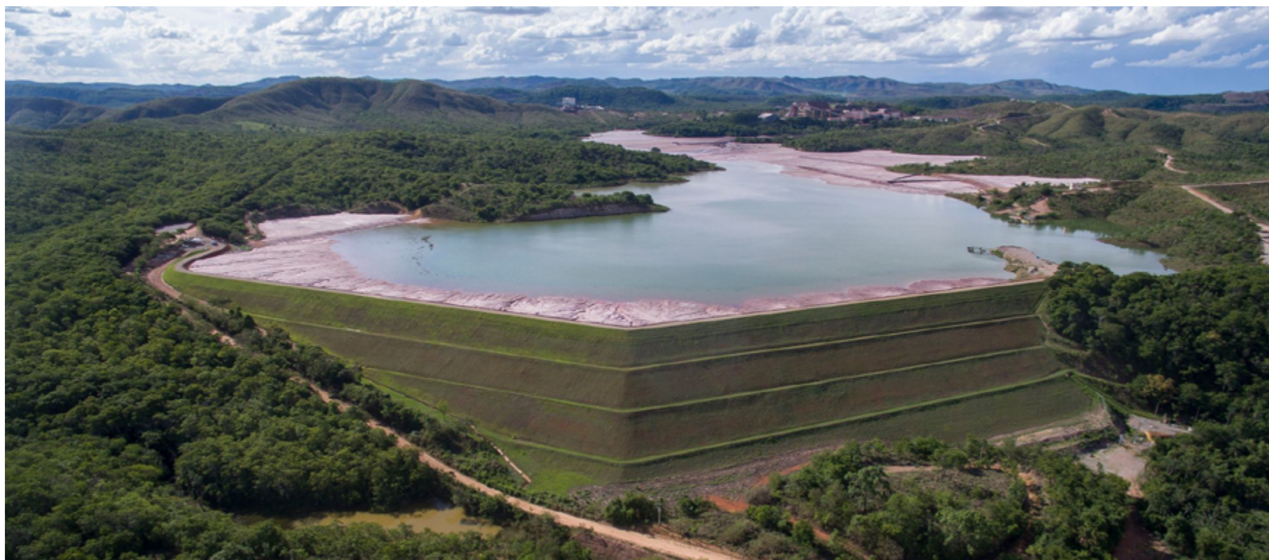
Barragem Aroeira, localizada na unidade de Vazante (MG)
